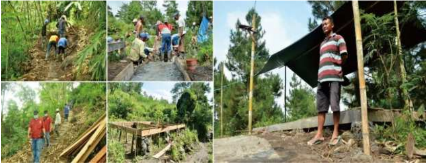
Kegiatan Pembangunan Tempat Evakuasi Sementara (TES). Perataan dan pelebaran jalur menuju lokasi, perabatan/pengerasan jalur evakuasi, pengecoran umpak/landasan tempat berlindung (berdirinya tenda)
