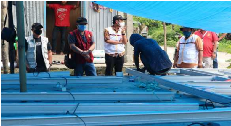
Proses Pembangunan hunian yang disponsori Caritas
